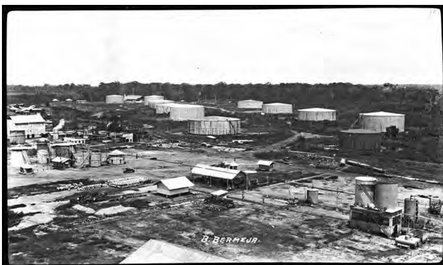
[Vista panorámica de la Troco] , Barrancabermeja, c. 1926. Vista aérea de la Tropical Oil Company.
