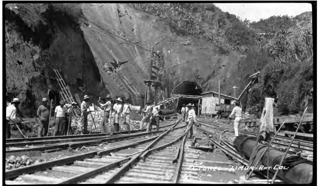
El Túnel - Limón - Antioquia - Colombia , El Limón, c. 1928. Existe información familiar sobre una temporada laboral de Floro en el Ferrocarril de Antioquia. Esta interesante fotografía da cuenta de la evolución de los trabajos de esta importante obra para mejorar las conexiones de Antioquia con el mundo.
